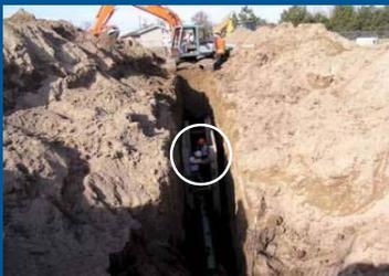
Proximidad de equipo pesado y la pila de despojos en el borde derecho de la excavación tanto crean una carga de pago. El sistema de protección en esta foto no se extiende lo suficiente hasta el foso para proporcionar protección adecuada a los dos trabajadores de la trinchera.
