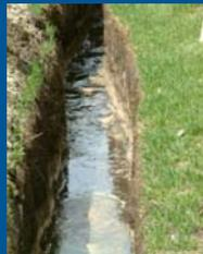
Soportes especiales o sistemas de protección pueden ser necesarios si se acumula agua en el piso de la zanja.
