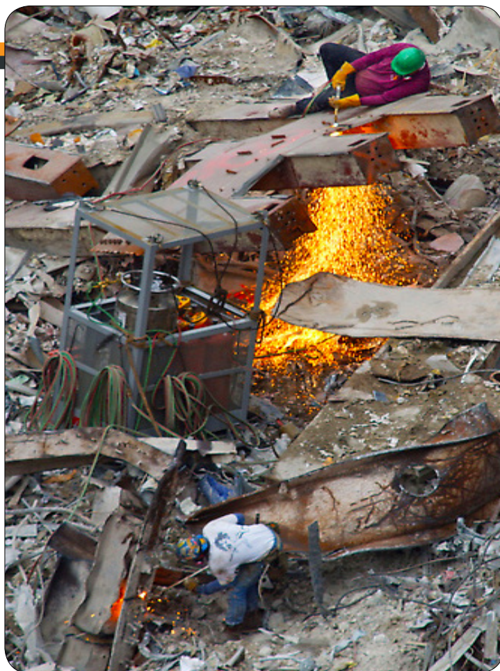
Иллюстрация: Два сварщика работают чтобы освободить части разрушенных материалов после падения Всемирного Торгового Центра в Нью-Йорке в Четверг, 27 Сентября 2001 года.
